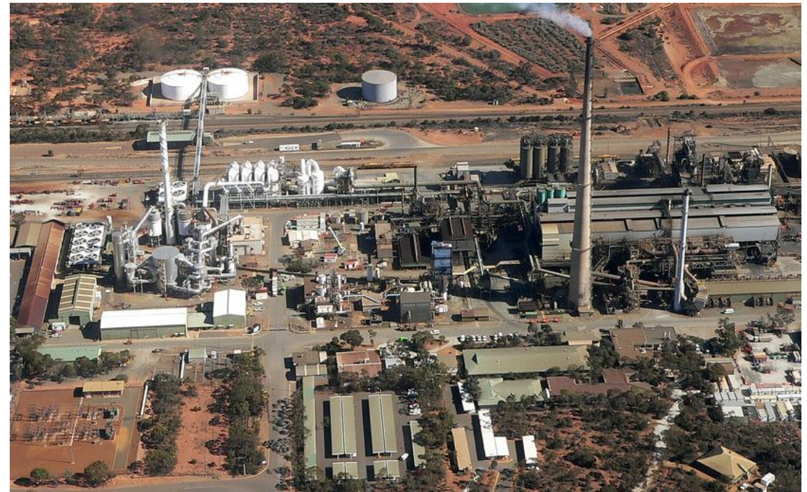
Kalgoorlie Nickel Smelter
